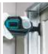
Retirada del marco de ventanas.
