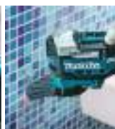
Encaje de juntas en revestimiento cerámico.
