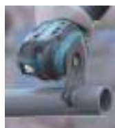
Corte de tubos de PVC.
