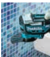
Encaje de juntas en revestimiento cerámico.
