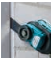
Corte de masilla de ventanas, silicona.
