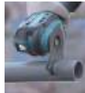
Corte de tubos de PVC.
