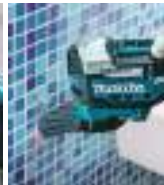
Encaje de juntas en revestimiento cerámico.
